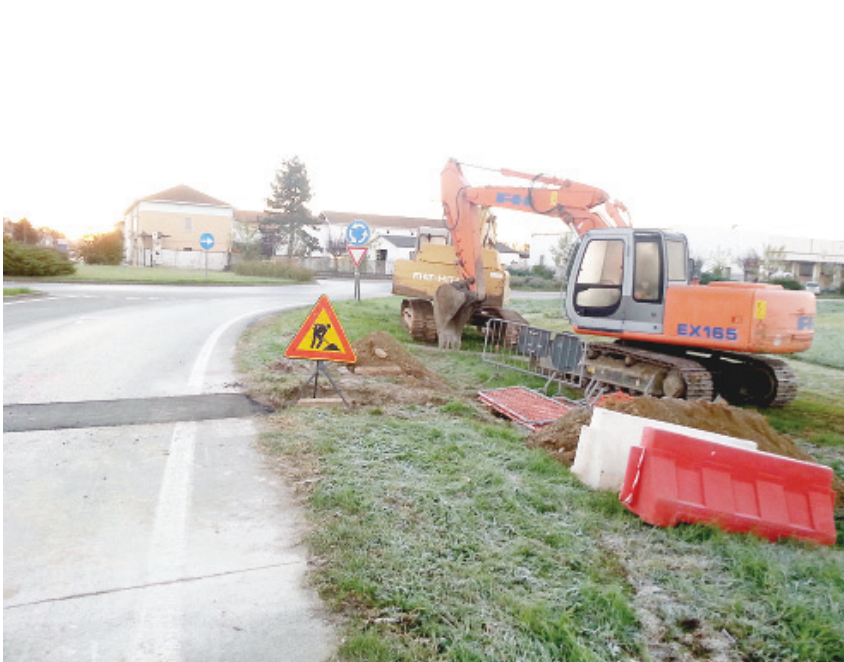
Il nuovo cantiere all'ingresso del paese
